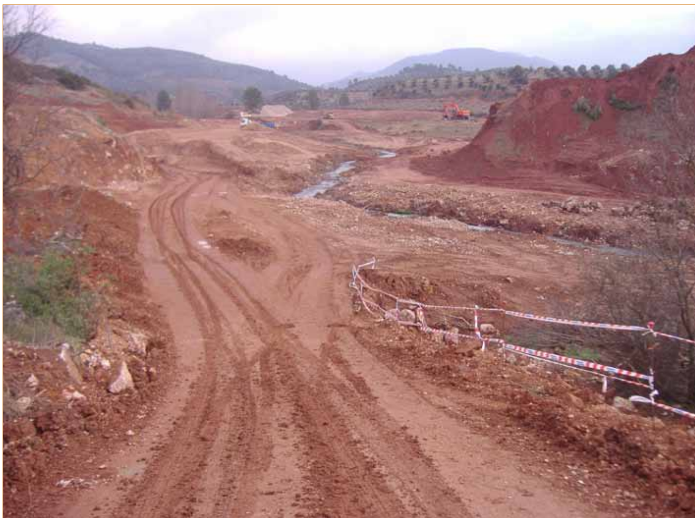
Obras del embalse de Siles (Jaén). Foto: Leandro del Moral
