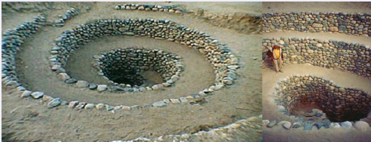
Figura 5.11: Sistema de captación de agua para acueductos subterráneos y para recargar las capas freáticas en Nazca (costa del sur de Perú).
