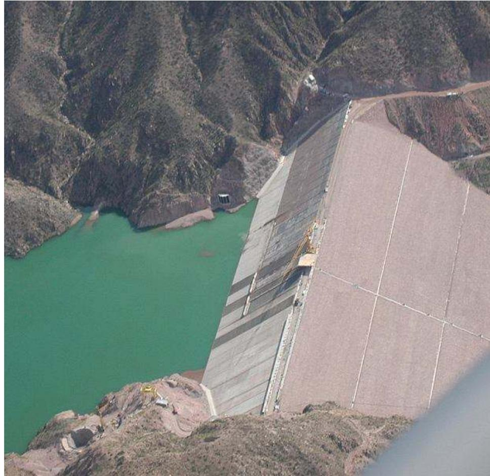
**GRAVAS COMPACTADAS CON PANTALLA DE HORMIGON ARMADO**
