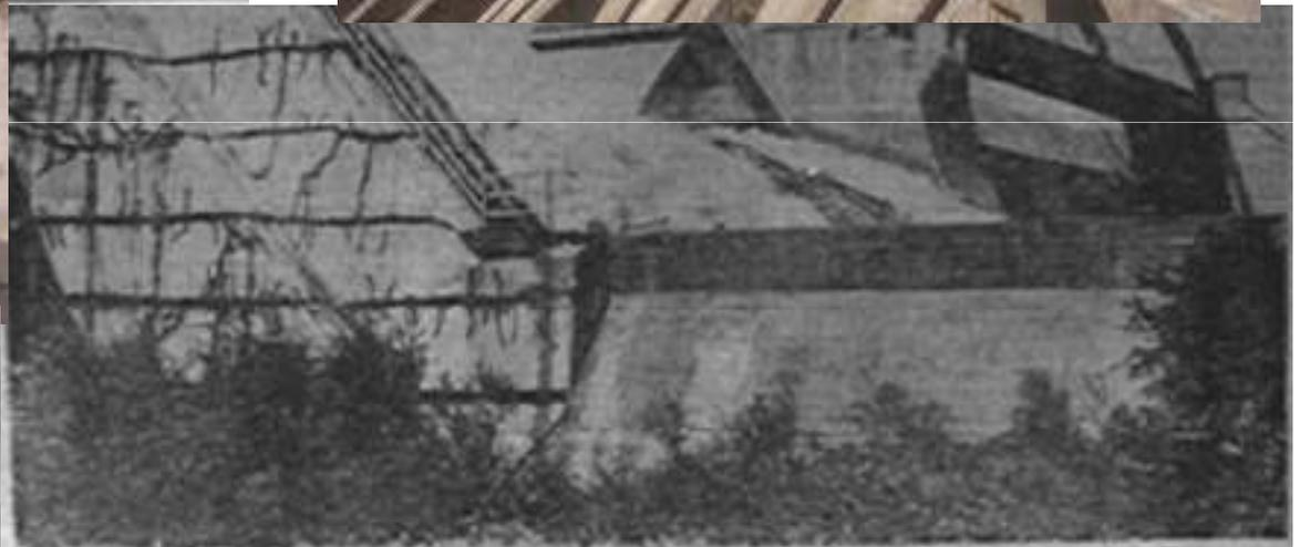
A las 2.15 de la mañana, cuando el Dique de Cruz del Eje esperaba en su construcción en una sección de 25 metros, se produjo el desplazamiento de uno de los pilotes. El agua comenzó a gotear, formando un charco de la ciudad de Cruz del Eje, una tragedia.
