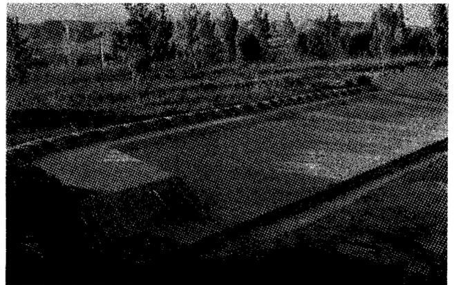
Fig. 3. La “Contraparada” en el río Segura: presa que da origen a las antiguas acequias de las vegas de Murcia y Orihuela. (Figura tomada de «Catálogo de Treinta Canales Españoles anteriores a 1900», de J. A. Fernández Ordóñez. C.E.H.O.P.U.).
