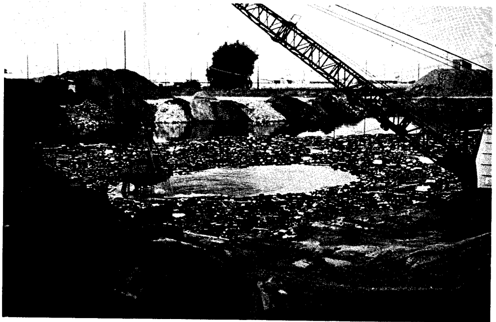
Fig. 7. Excavación para extracción de arenas en el delta del Llobregat y relleno simultáneo con escombros y basuras. Alto potencial contaminador y larga persistencia.
