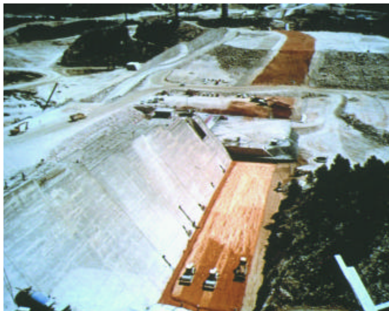
Figura 6: Zonas de contacto entre los bloques de hormigón de la antigua presa y el nuevo núcleo de arcilla.
