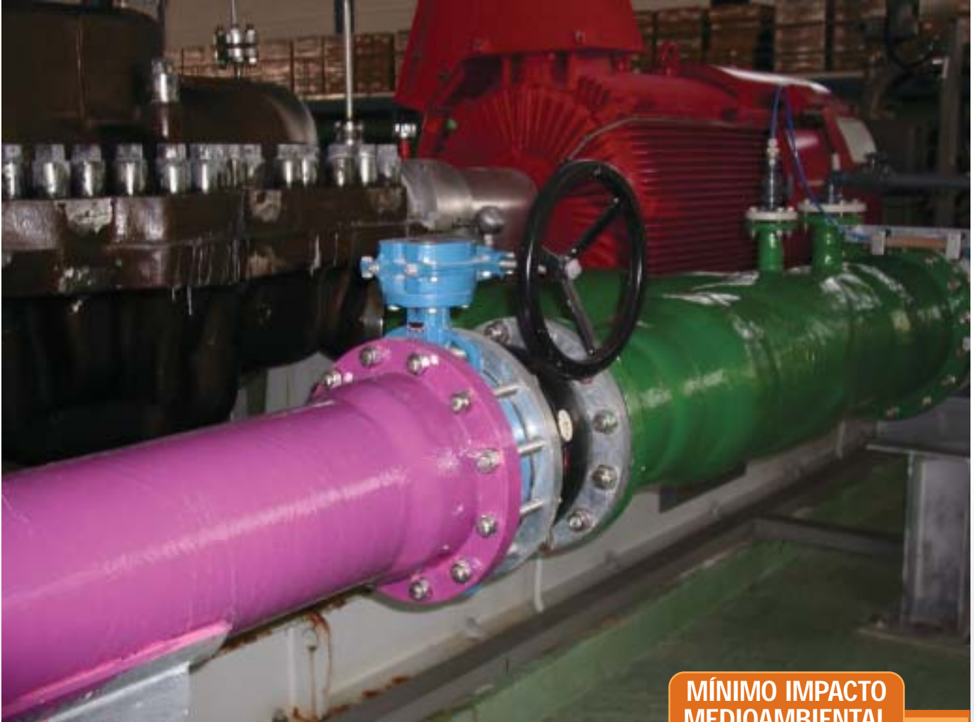
El procedimiento de desalación es el de ósmosis inversa.
