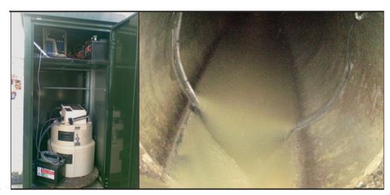
FIGURA 1. Sección de control (izq.) e instrumentación instalada en el colector (dcha.).
