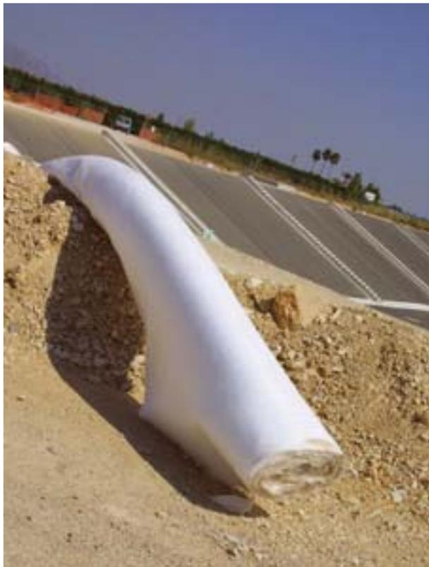
FIGURA 2. Rollo de geotextil empleado en la balsa de Torrealta-2. (La Murada-Orihuela. Alicante).
