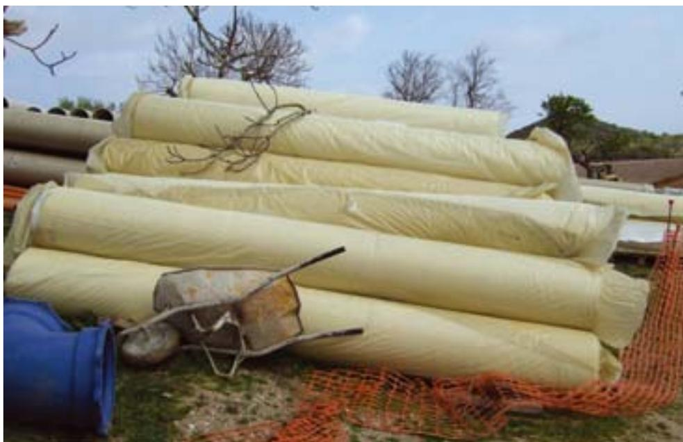
**FIGURA 1.** Geotextiles utilizados en el sistema de impermeabilización en la balsa de Capdepera.
