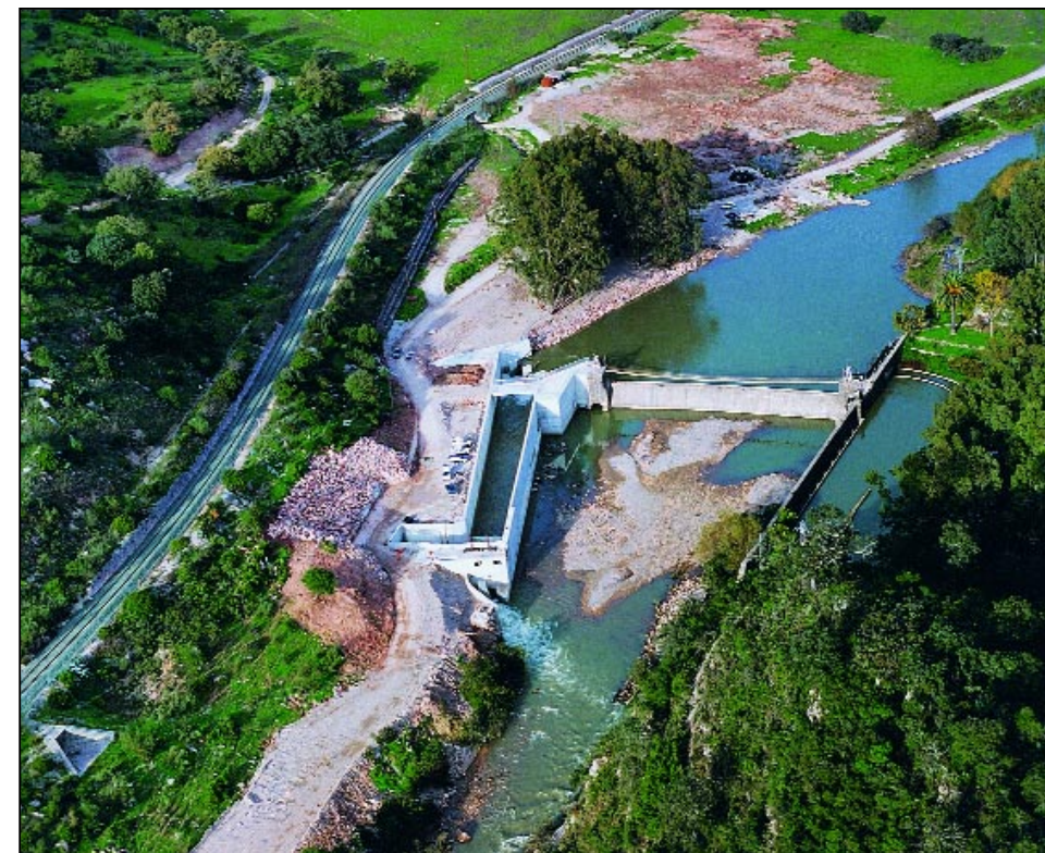
Obra de toma del trasvase Guadiaro-Guadalete.
