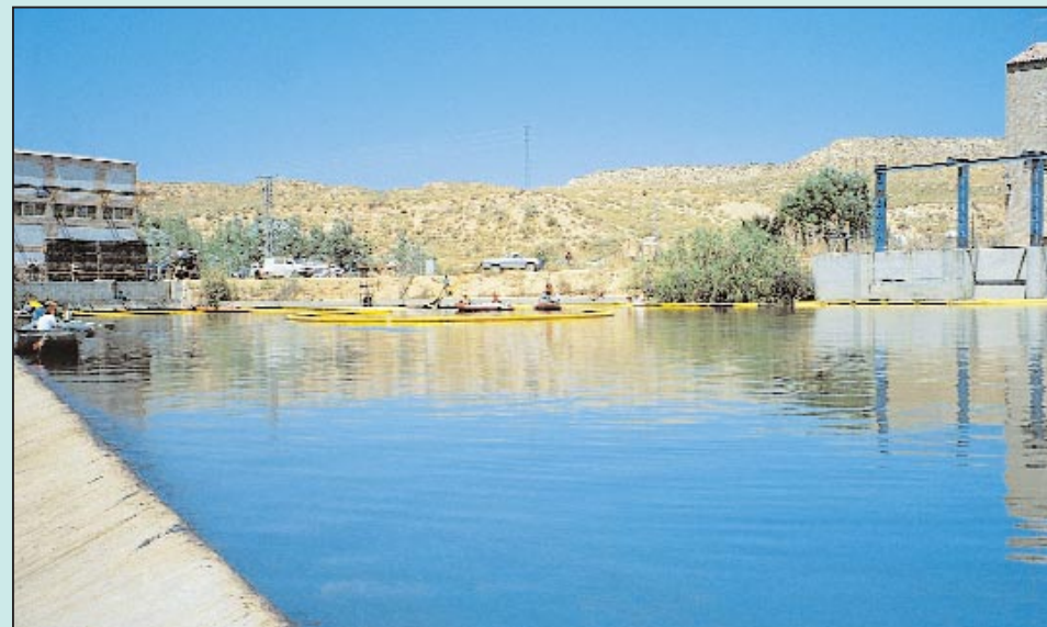
Una de las barreras de contención se instaló cerca de la presa.
