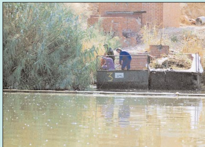
Operarios realizando la corta de la vegetación desde una balsa, ya que era imposible realizar estos labores desde la orilla.
