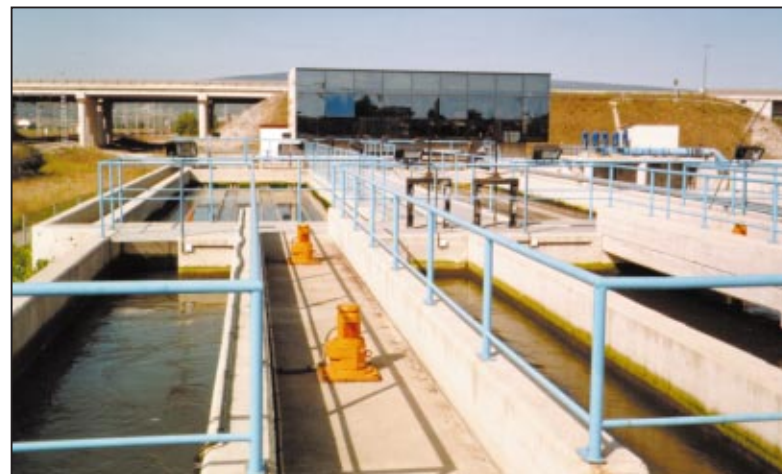
Planta de Arrato. Foto: TYTSA. Vitoria.
