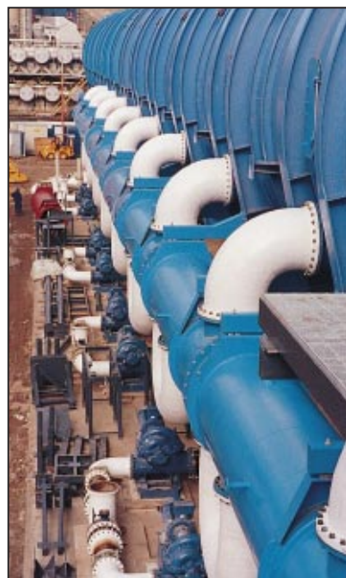
Cámaras de flash y bombas de alimentación de la planta desaladora Las Palmas-Telde. Foto cedida por INIMA.
