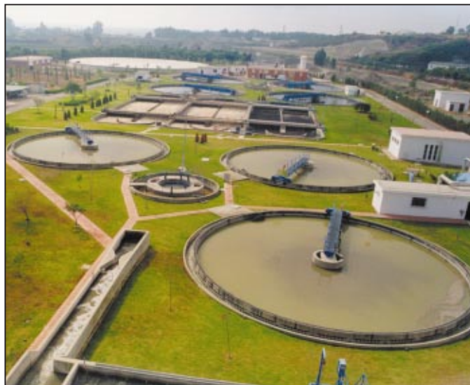
Planta de depuración de aguas residuales de Estepona (Málaga).
