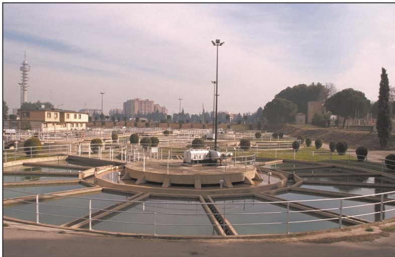
Planta potabilizadora de Casablanca. Foto cedida por el Ayuntamiento de Zaragoza.
