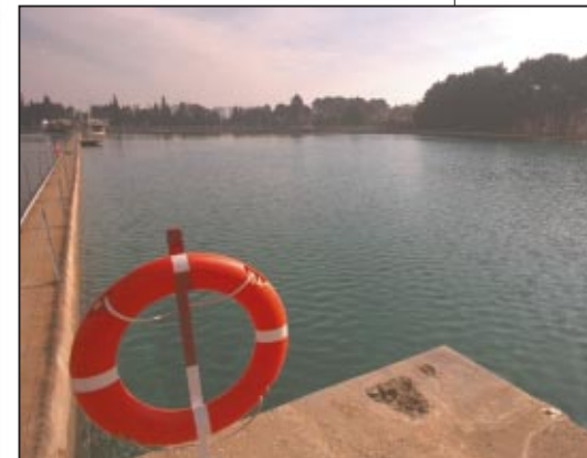
Depósitos de regulación de la planta potabilizadora de Casablanca.
