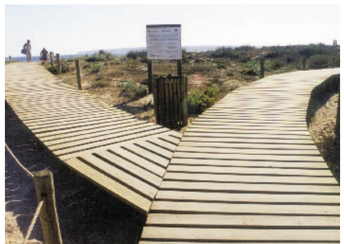
La construcción de pasarelas peatonales canaliza el flujo de visitantes.
