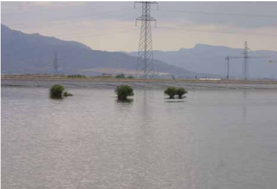
FIGURA 2. Balsa de Los Cabezos (Villena-Alicante) cuya pantalla impermeabilizante está constituida por polietileno de alta densidad.
