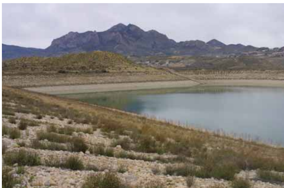
FIGURA 3. Balsa de Plá Mateos (Alicante) cuya impermeabilización se realizó con polietileno de baja densidad.
