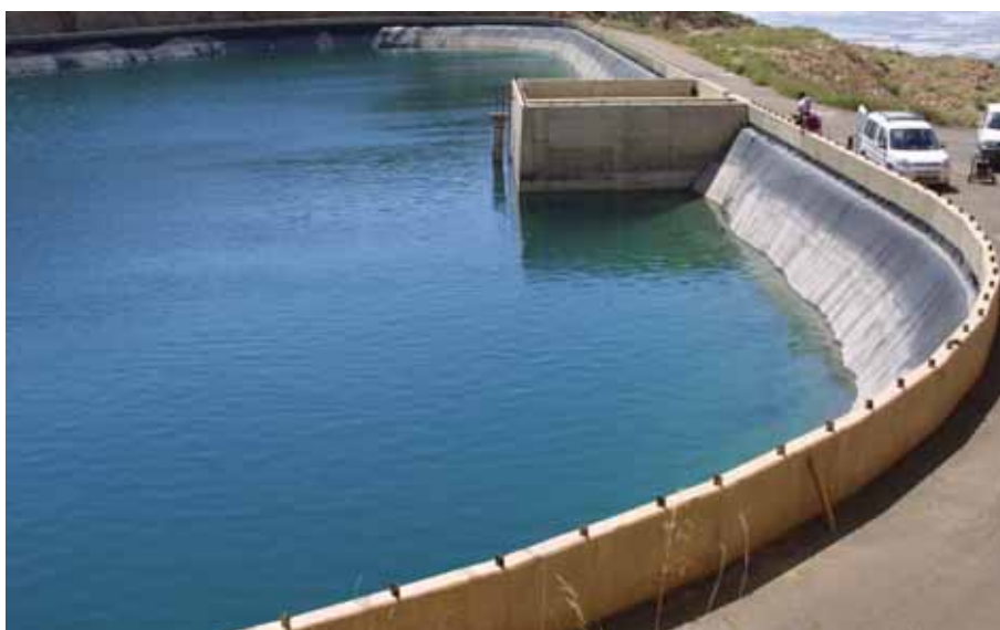
FIGURA 1. Balsa de El Cerrillo del Libro (El Éjido-Almería) impermeabilizada con polietileno de muy baja densidad.
