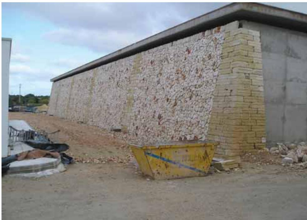
**FIGURA 2.** Depósito de almacenamiento de agua tratada en la IDAM de Ciutadella (Menorca) actualmente en fase de construcción. Se puede apreciar cómo se cumplen los condicionados de la DIA respecto a la integración paisajística, al emplear piedra natural para recubrir las estructuras aéreas.
