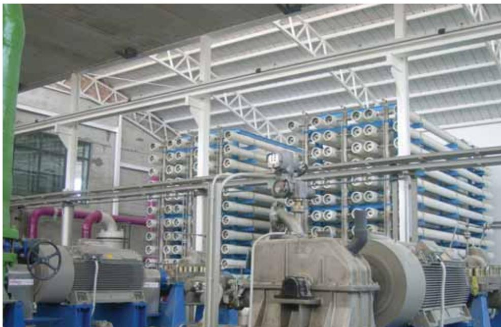
**FIGURA 1.** Bastidores de ósmosis inversa, instalados en la IDAM de Santa Eulalia (Ibiza).
