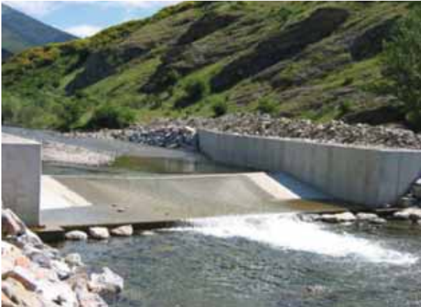
FIGURA 2. Ejemplo de estación de aforos de tipo V-flat donde son patentes muchos de los problemas descritos en el texto (río Carrión en Triollo, Palencia).
