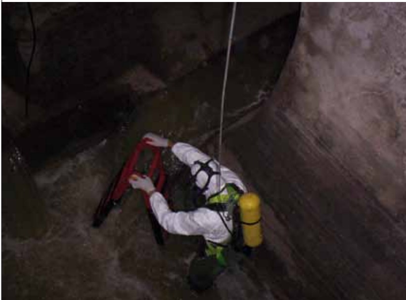
Figura 22. Instalación de métodos de medida en un colector.
